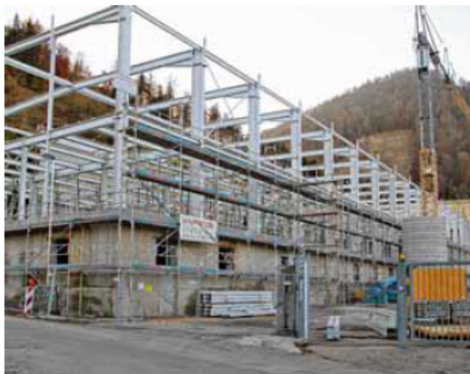
Im Zeitplan liegt der Bau der neuen Produktionshalle im Monta-Klebebandwerk in Immenstadt. Auf das bestehende Kellergeschoss wurde eine Stahlkonstruktion montiert. Derzeit werden Beton-Fertigteile an den Wänden eingesetzt. Dass noch vor Wintereinbruch das Dach auf die Halle kommt, hofft Geschäftsführer Johann Amoser (rechts).
